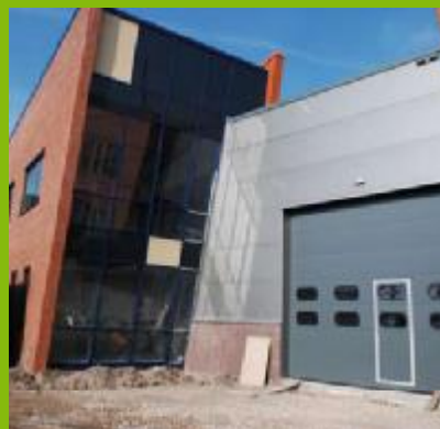
Het nieuwe pand van de technische dienst.
